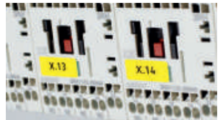
Kendinden yapışkanlı cihaz etiketi
